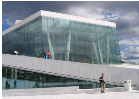
Bild 6. Schillernde Glasfassade des Foyers
