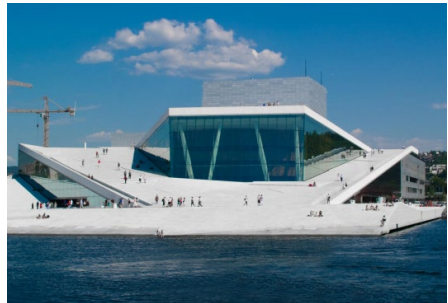
Bild 3. Das Opernhaus Oslo mit öffentlich begehbare Dachfläche
